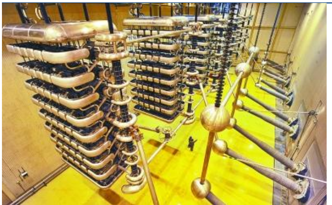
图表 99 江陵换流站换流阀大修后场景
