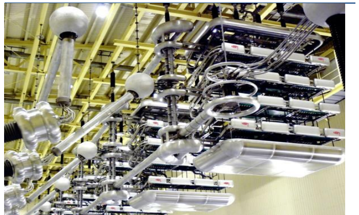
图表 100 许继为向家坝—上海特高压直流换流阀设备
